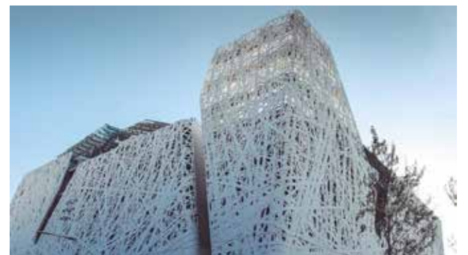
Palazzo Italia w Mediolanie - budynek pokryty elewacją z TiO 2 . Źródło: Giacomo Carena, Flickr (CC2.0)
