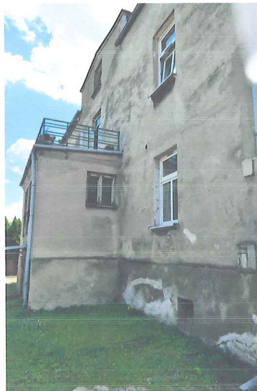
Elewacja zachodnia wiatrołapu budynku nr 71.
