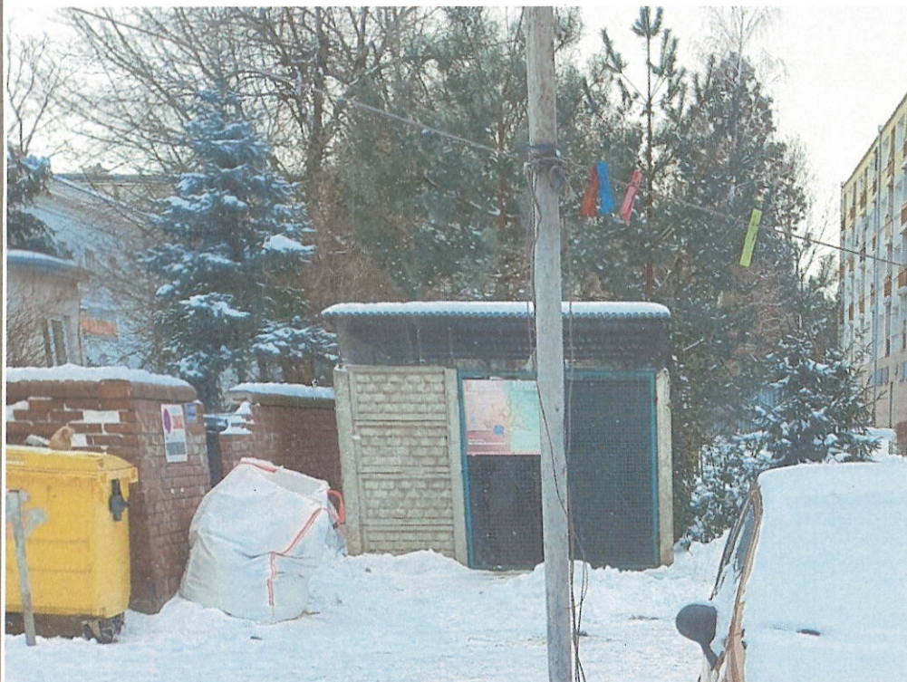
Foto1. Widok w kierunku zachodnim
