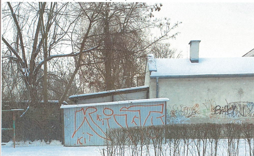
Widok w kierunku zachodnim - garaż z obiektem o tej samej funkcji na działce 13/32.
