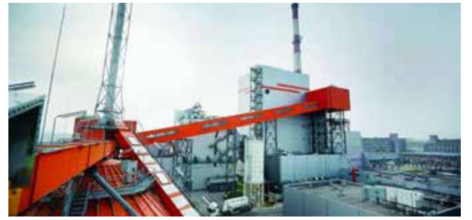
trociepłowni Fortum w Częstochowie.
