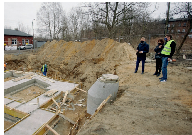
na zdjęciach: plac budowy budynku przy ulicach Władysława Syrokomli i Aleksandra Fredry (29 marca 2021 roku)
