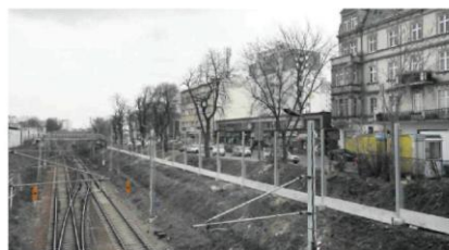
• Budowa ekranów dźwiękochłonnych przy ul. Wilsona
