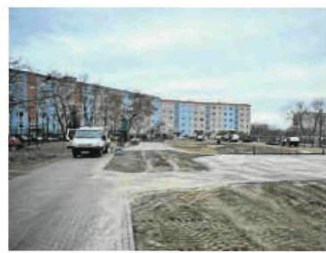
Budowa rozpoczęła się we wrześniu 2020 roku, a zakończy się na początku 2021 roku
