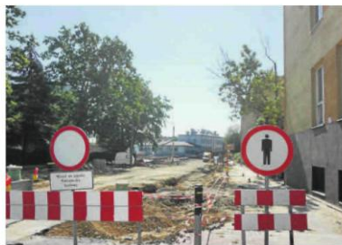
W centrum miasta remontowane obecnie są m.in. ulice Korczaka i Boya-Żeleńskiego
