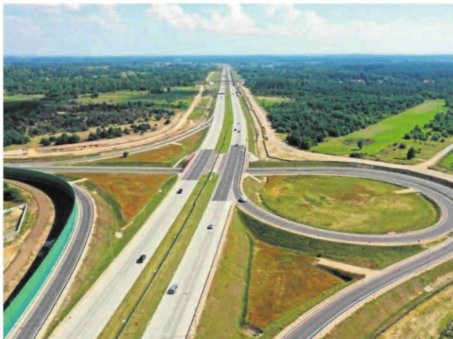
Autostrada A1, odcinek F. Okolice węzła Blachownia
