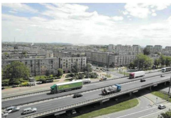
• Estakada rakowska będzie rozbierana i budowana na nowo
