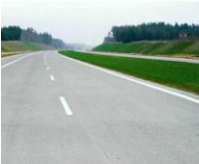
Autostrada A1, obwodnica Częstochowy, M. SPG
