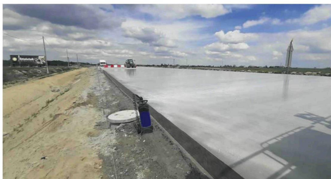
• Drogowcy kładą betonową nawierzchnię na odcinku AI Częstochowa – Tusznyn k. Łodzi. FOT. GDDKiA
