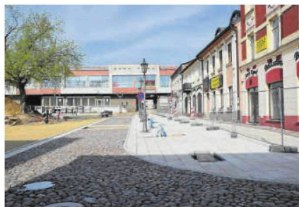
Na Starym Rynku w Częstochowie trwają intensywne prace. Inwestycja zakończy się w tym roku
