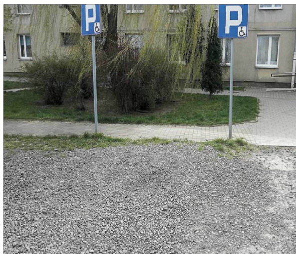
Nieoznakowane kopertą miejsce dla niepełnosprawnych jest niezgodne z przepisami ruchu drogowego
