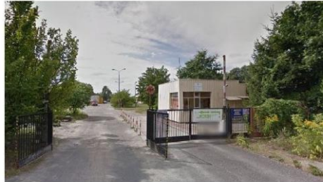
Koniec ul. Dojazdowej, to tu Fortum chciałoby założyć wytwórnię paliwa alternatywnego StreetView
