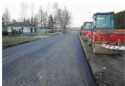
Część dróg już została wyremontowana. Wśród nich jest m.in. ulica Fiołkowa w dzielnicy Kiedrzyń
