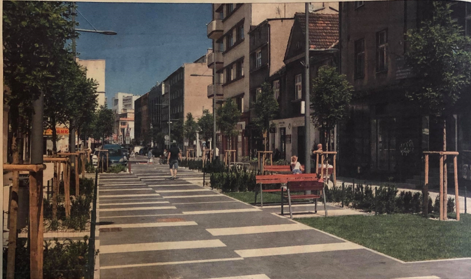
Pierwszy gdynski woonerf na ulicy Abrahama. To przestrzeń współdzielona, w której piesi mają bezwzględny priorytet przed samochodami, oddana do użytku latem 2019 roku. Projekt był zwyciężcą w budżecie obywatelskim, a Miasto Gdynia zwiększyło kwotę na jego wykonanie, co pozwoliło na wymianę całej infrastruktury podziemnej
