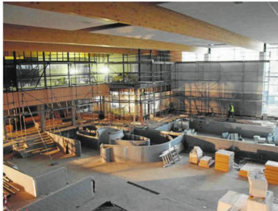
Tak wygląda obecnie wnętrze aquaparku. Prace przebiegają zgodnie z harmonogramem
