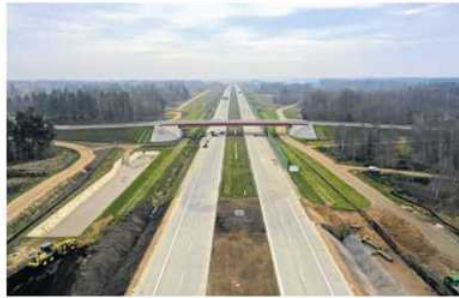
• Fragment obwodnicy Częstochowy w okolicach Blachowni
