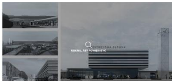
Nowy dworzec PKP w Częstochowie to będzie pasaż nad peronami, wsparty z dwóch stron przeszklonymi miejscami obsługi pasażerów (fot. pkip.pl)
