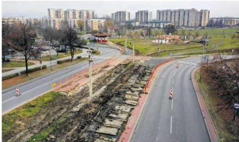
• Z al. Wyzwolenia znikają stare torowisko. Nietknięty zostanie tylko zmodernizowany już odcinek nad przejściem podziemnym. FOT. GRZEGORZ SKOWRONEK / AGENCJA GAZETA
