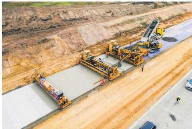
Główne prace są mocno zaawansowane. Jak informuje Generalna Dyrekcja Dróg Krajowych i Autostrad, nawierzchnia betonowa ma zostać ułożona jeszcze w tym miesiącu
