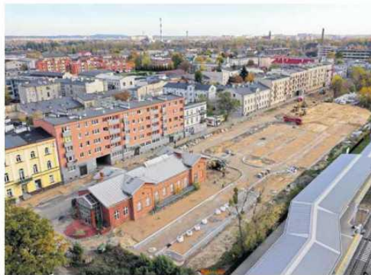
• Ulica Piłsudskiego. Budowa parkingu za Konduktorownią FOT. GRZEGORZ SKOWRONEK / AG
