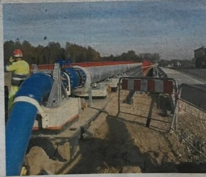
• Przebudowany wodociąg na przecięciu z budowaną autostradą A1 FOT. GÓRKA
