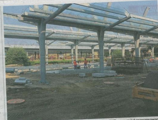
Przy budowanym centrum przesiadkowym w okolicach dworca PKP prace są już zaawansowane
