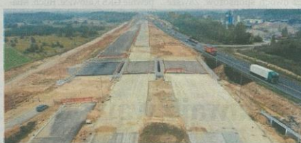
Autostrada A1 w pobliżu węzła „Częstochowa Północ”
