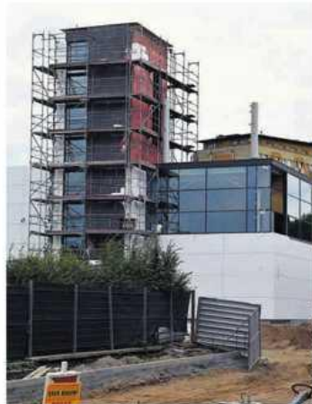
Elewacja parku wodnego jest już niemal kompletna
