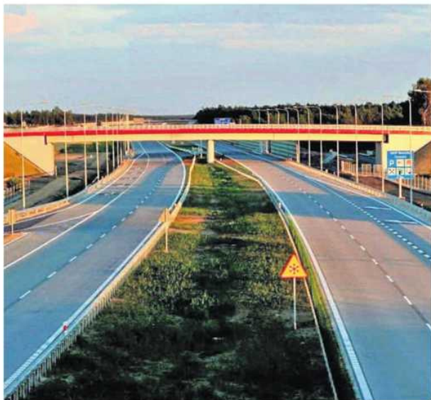
Budowa A1 trwa, a samorządowcy proszą premiera o pomoc w remontach dróg lokalnych
