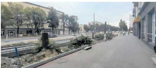
• Przebudowywany przystanek tramwajowy w al. Pokoju. FOT. KAMIL RAJCZYK
