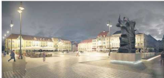
Rewitalizacja Starego Rynku w Bydgoszczy jest już na finiszu
