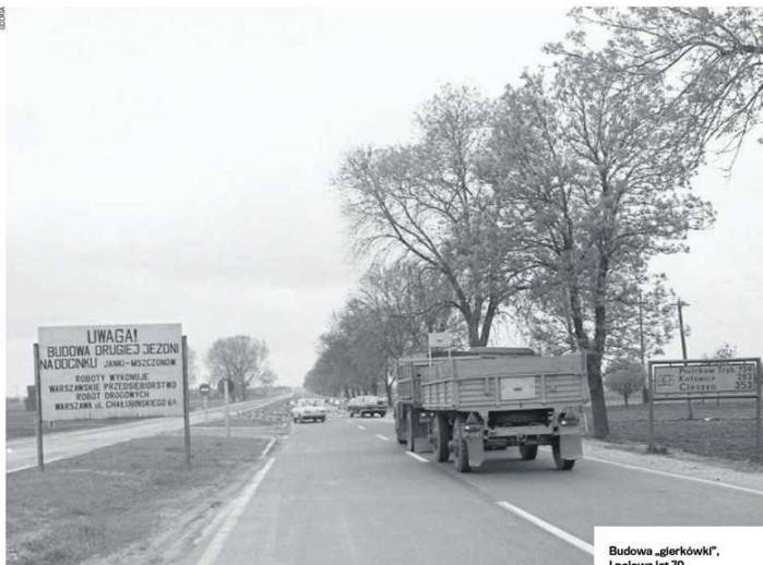
Budowa „gierkówki”. I połowa lat 70.
