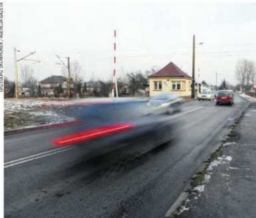
Od kilku lat trwają intensywne zabiegi, by nad torami przy ul. Bugajskiej zbudować wiadukt. Na razie nie ma na to pieniędzy
