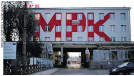
Zmiana wyglądu biurowca MPK przy al. Niepodległości wiąże się z przeprowadzoną w nim termomodernizacją
