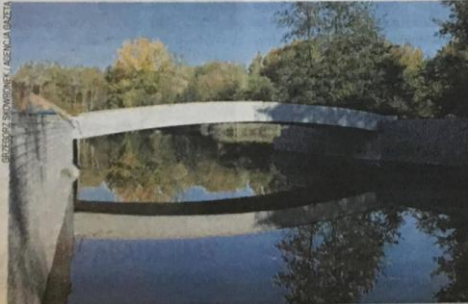
Budowa kładki w parku Lisiniec
