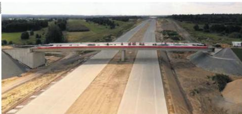
Betonowa nawierzchnia autostrady koło Starczy. Galeria zdjęć z drona: czestochowa.wyborcza.pl
