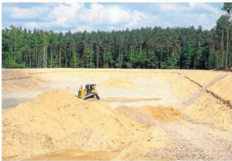
W lipcu zakończone zostaną prace związane z odwodnieniem dzielnicy Grabówka. Prace obejmą również Kiedrzyń
