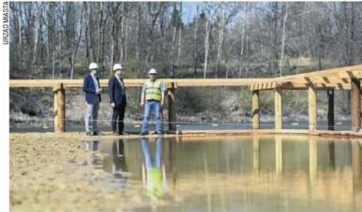
Prezydent Krzysztof Matyjaszczak (w środku) na budowie kąpieliska nad zbiornikiem Adriatyk
