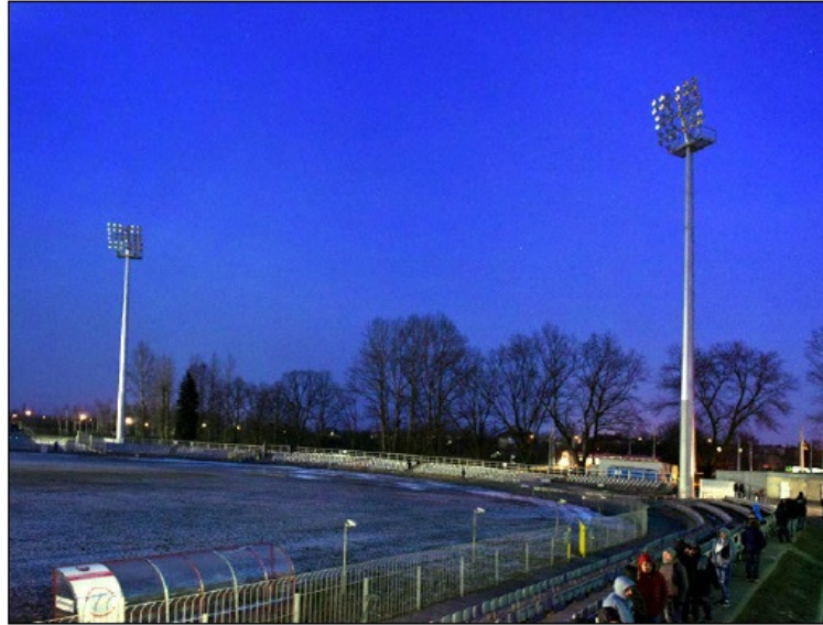
Główna płyta na obiekcie przy ul. Limanowskiego będą oświetlać w czasie zawodów sportowych 152 jupitery stojące na czterech 42-metrowych wielokątnych masztach.
