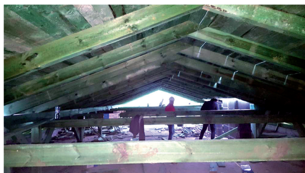
Prace budowlane przebiegają zgodnie z harmonogramem
