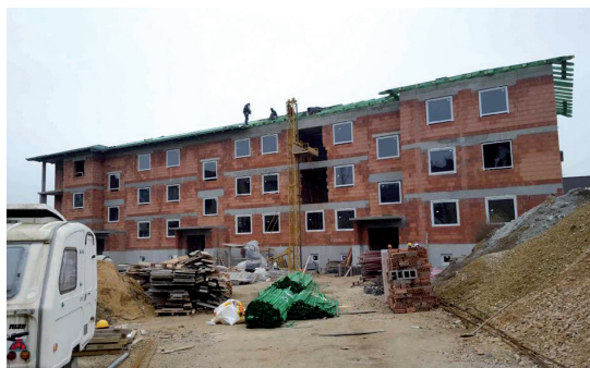
Blok przy ulicy Kontkiewicza jest gotowy w stanie surowym zamkniętym
