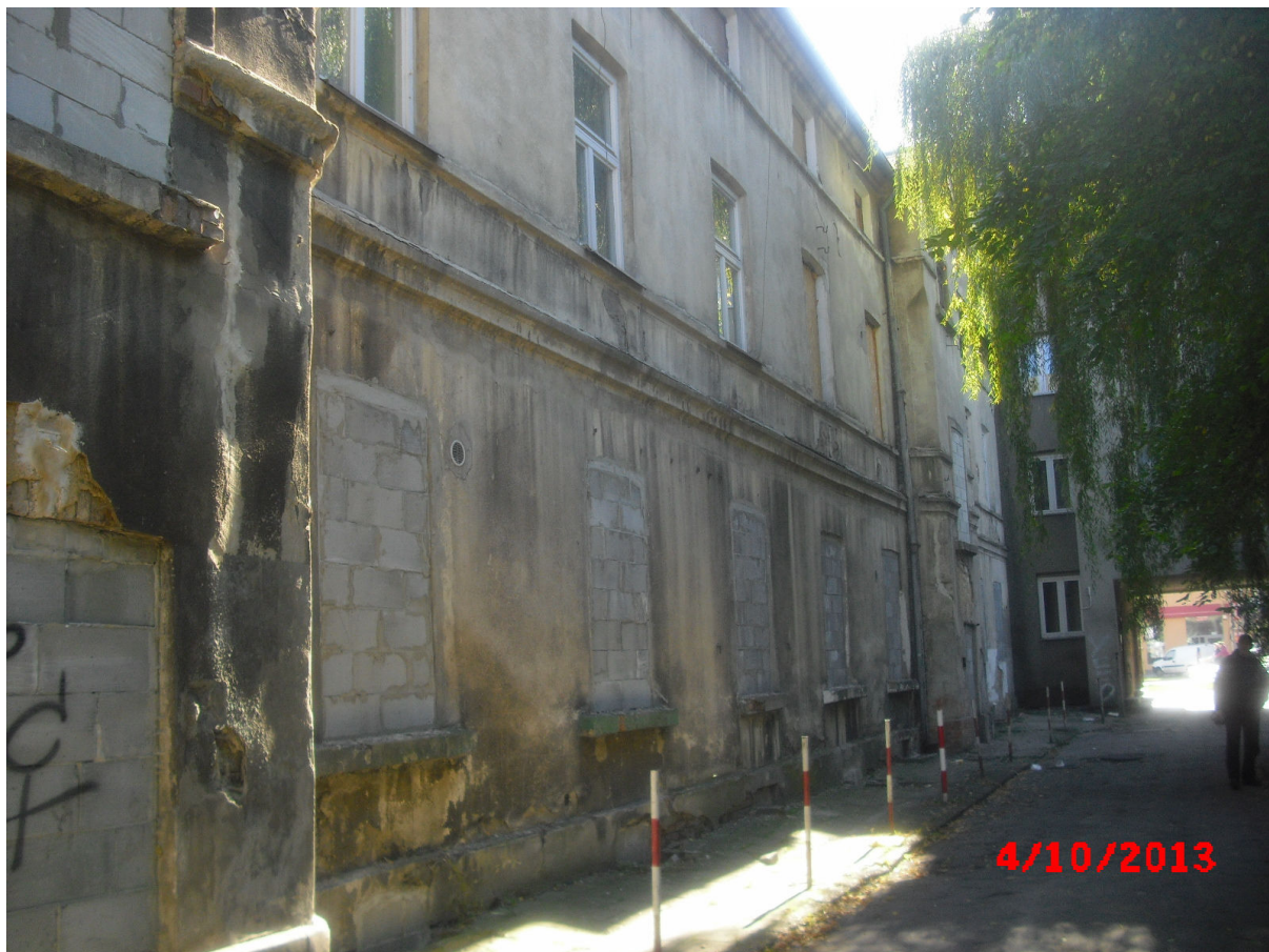
Ściana zachodnia – obiekt nr 1
