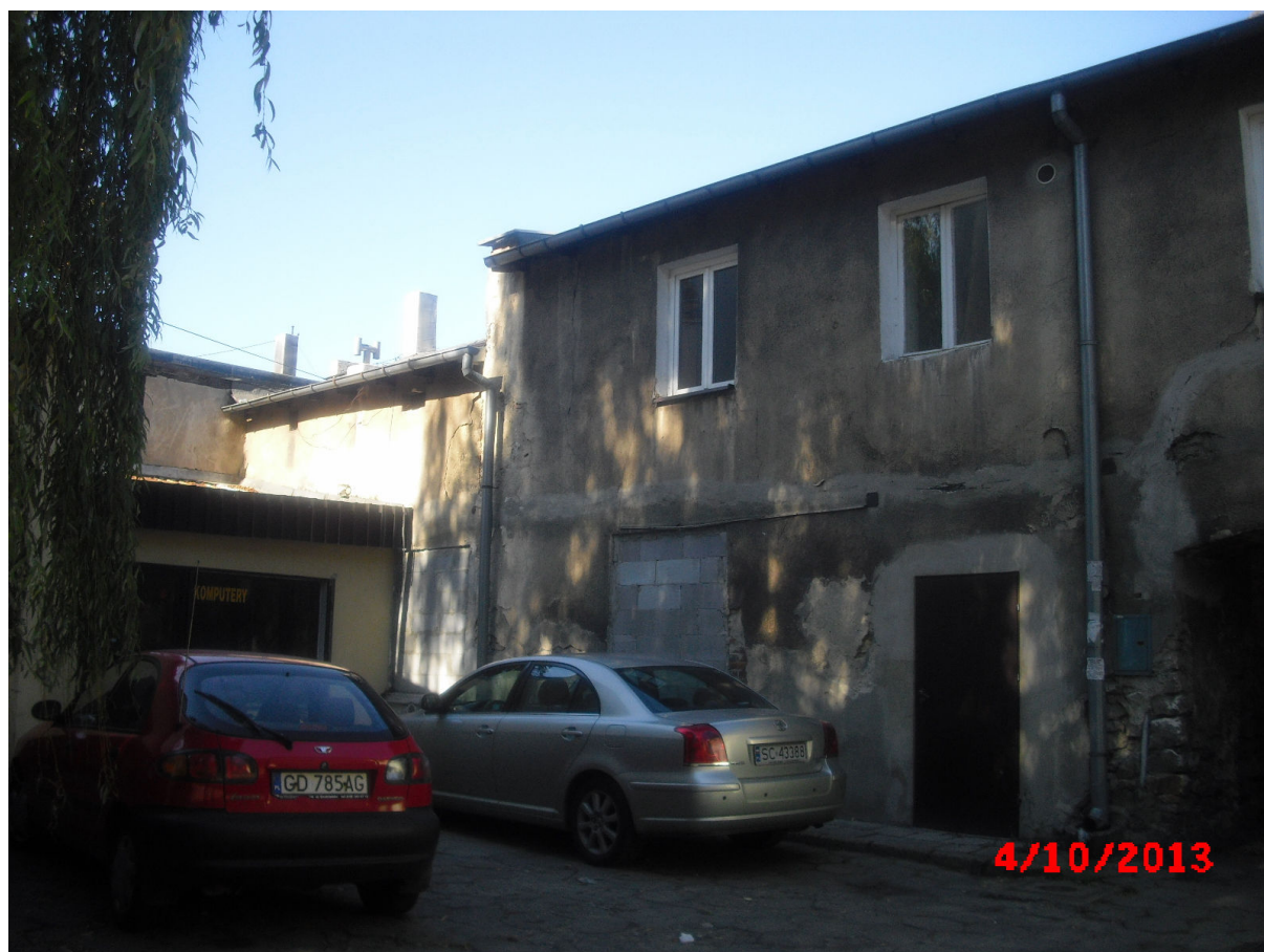
Ściana południowa – obiekt nr 2
