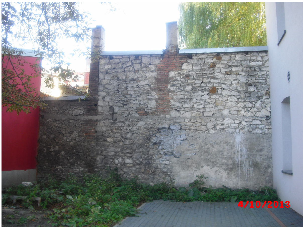
Ściana zachodnia – obiekt nr 3
