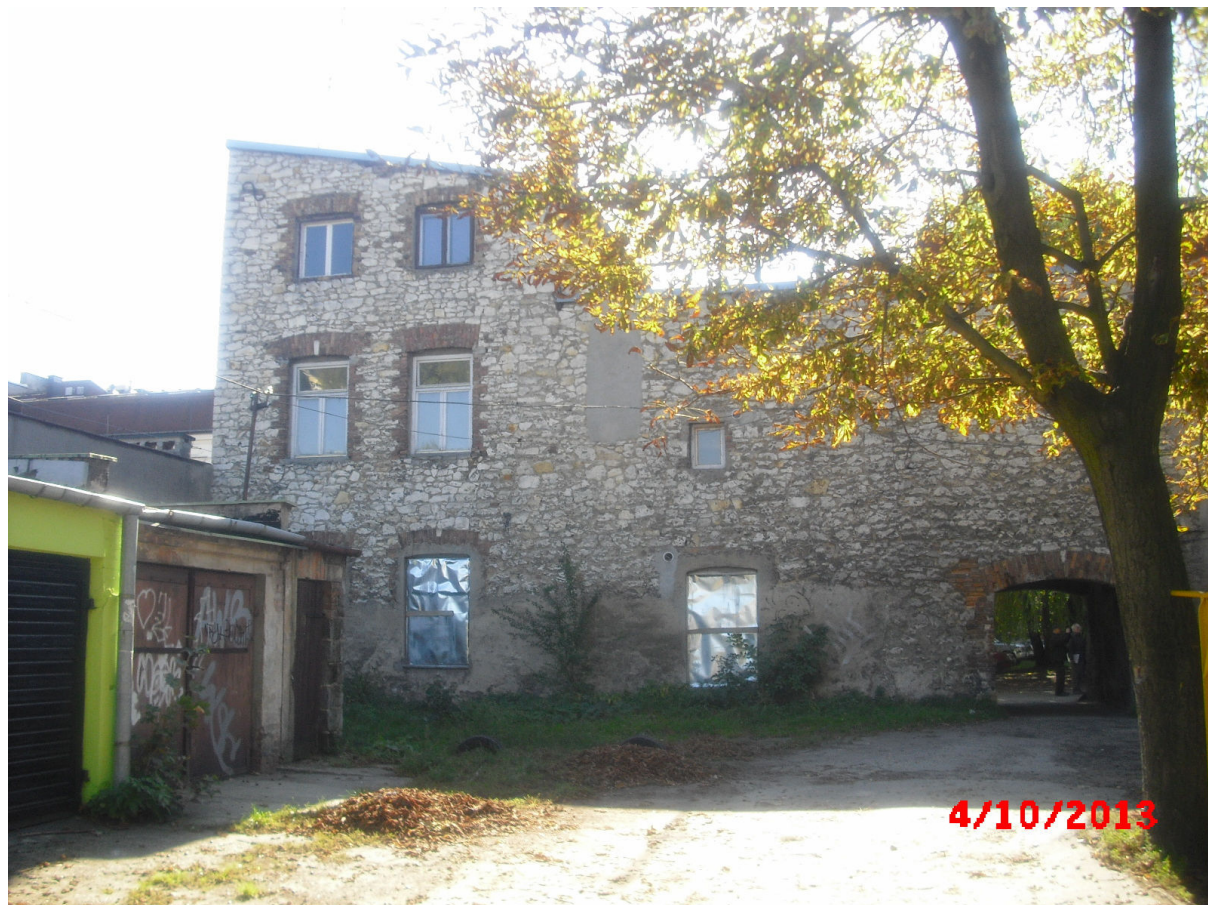
Ściany północna i wschodnia – obiekt nr 1
