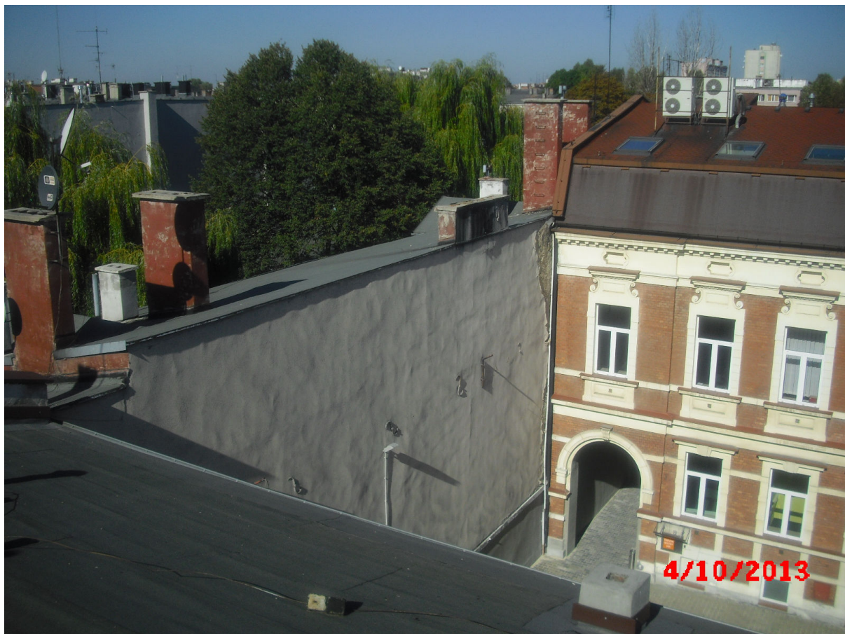
Poziom dachu – obiekt nr 1
