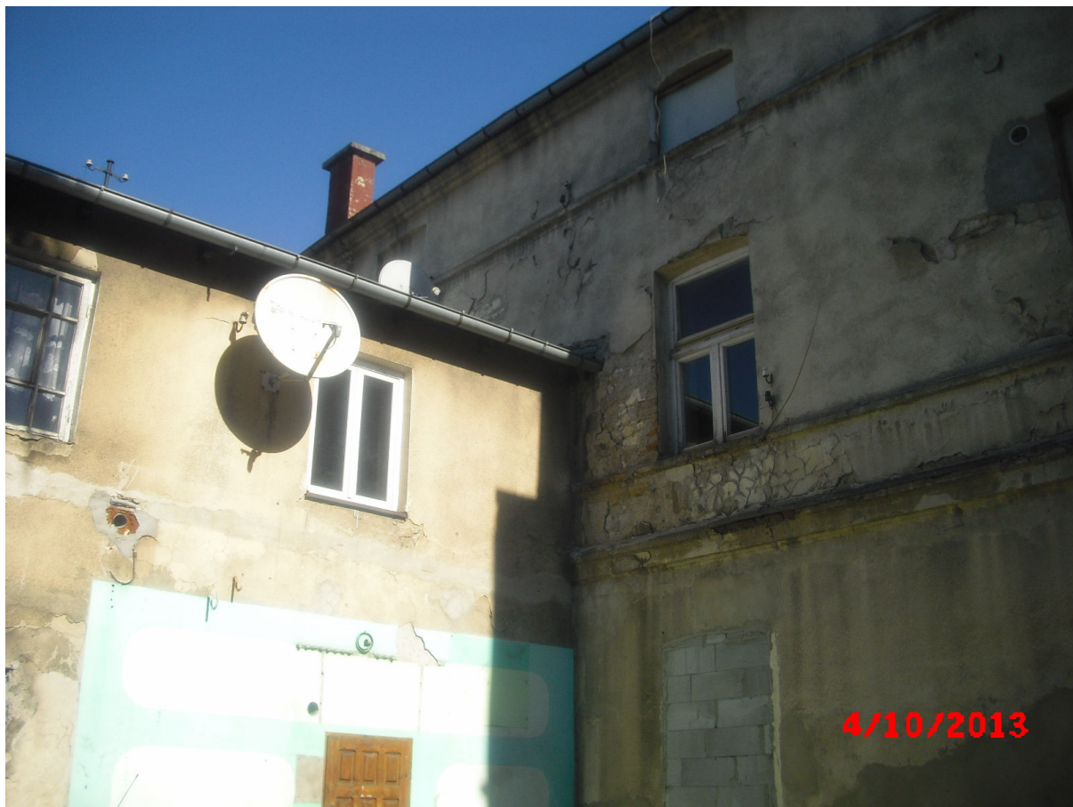
Ściany północna i południowa – obiekt nr 2
