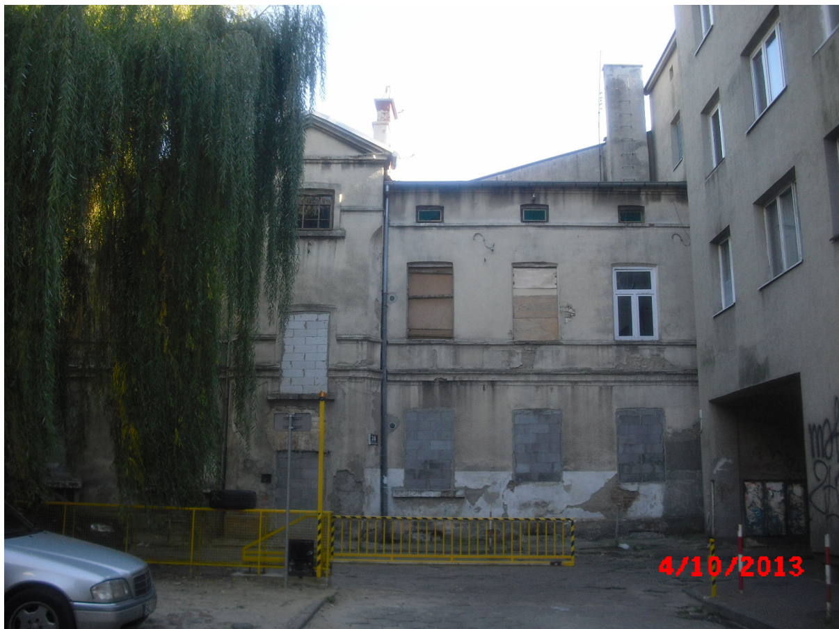
Ściana zachodnia – obiekt nr 1
