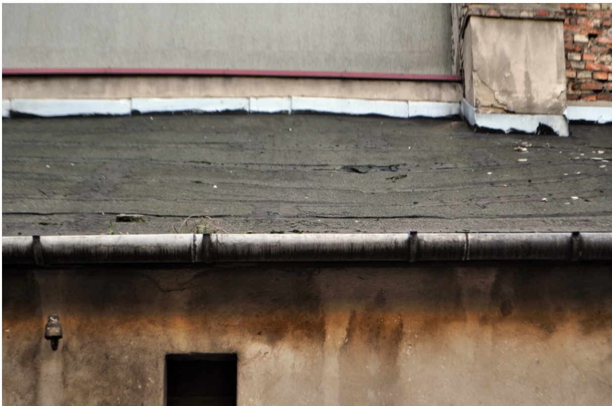
Widok załamanej konstrukcji dachu.
