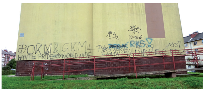
Zniszczona elewacja przy ulicy Kontkiewicza 4
