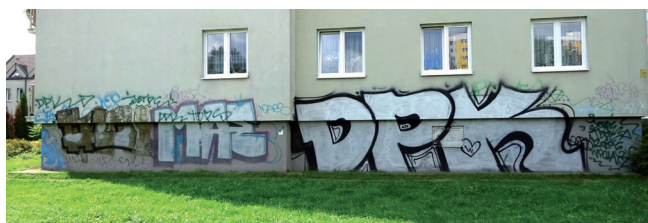
Zniszczona elewacja przy ulicy Czecha 2b
