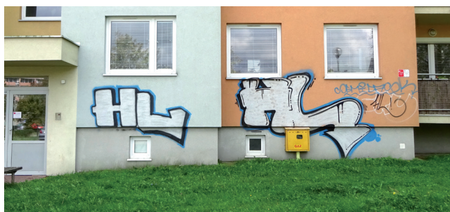
Zniszczona elewacja przy ulicy Herberta 5
